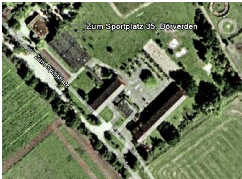
Abb. 2.9: Grundschule Westen / Hülßen (PV-Potential: ~ 140 kWp auf ~ 950 m 2 Dach)
