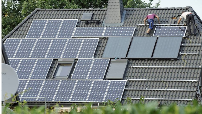
Abb. 2.16: kombinierte Photovoltaik- und Solarthermieanlage
